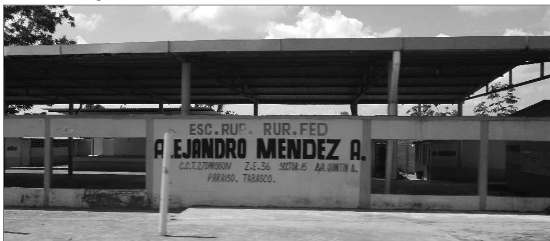
Fig. 139. Instalación de escuela rural en la localidad de Quintín Arauz
